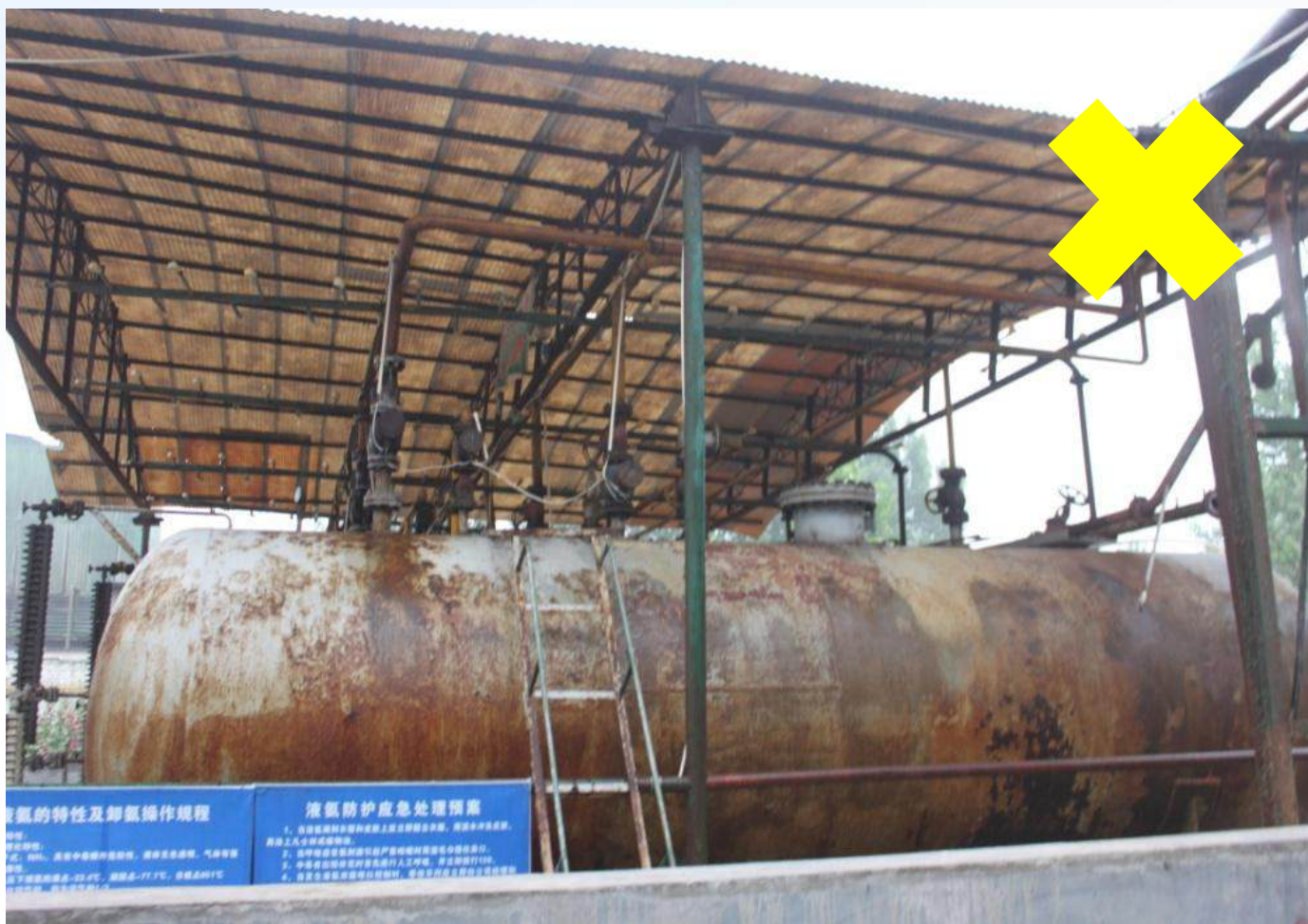
储罐腐蚀严重
