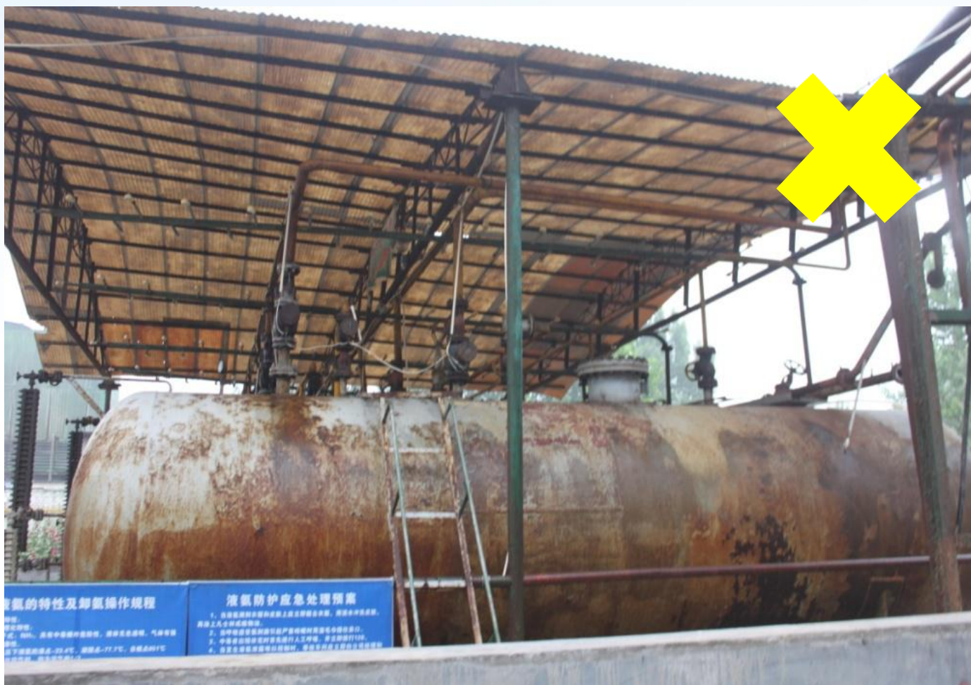
储罐腐蚀严重
