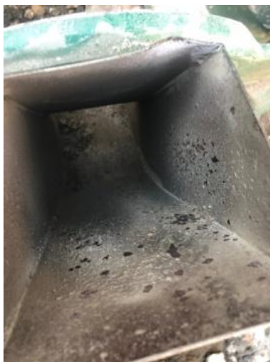
入料口管道内壁留下的过火痕迹
